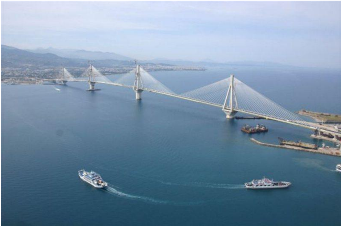
Γέφυρα Ρίου -Αντιρρίου
